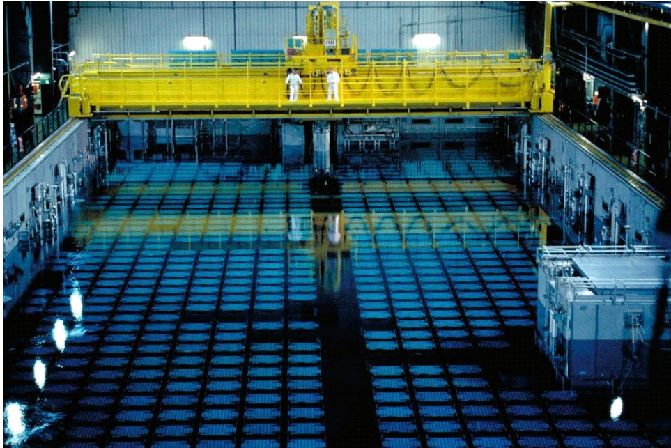
Fig. 12. Piscina d'emmagatzematge d'una central nuclear
