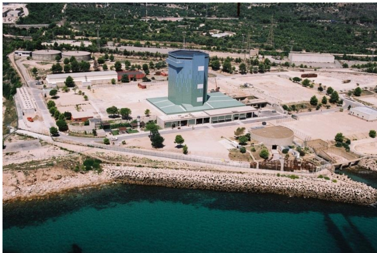
Fig. 10. La central nuclear de Vandellòs després que es construí el caixó protector durant l'etapa de latència
