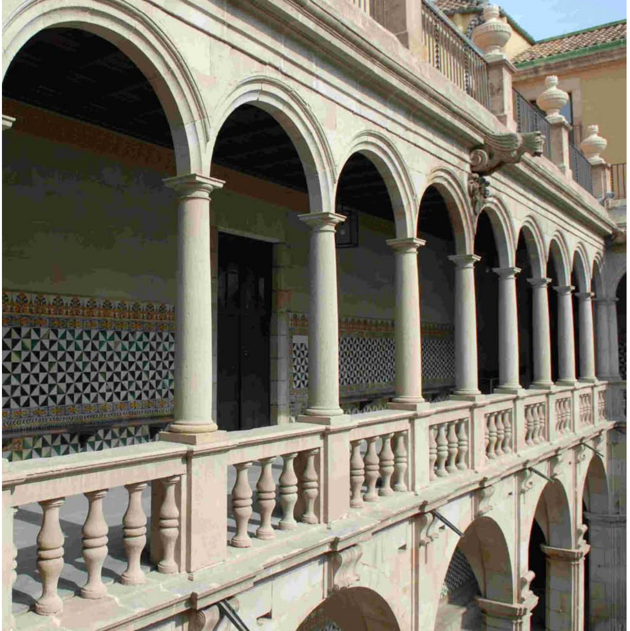
Galeria i claustre de la Casa de Convalecència
