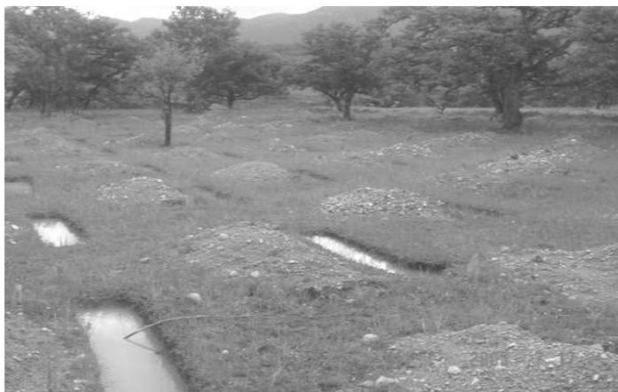
Figura 4. Tinajas ciegas. La tierra extraída se ubica aguas abajo, para que no impida la entrada del agua proveniente del escurrimiento (CONAFOR, 2004).
