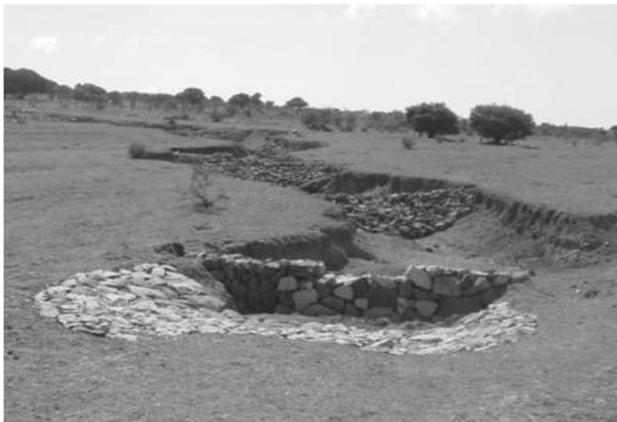
Figura 3. Cabeceo con piedra acomodada de una cárcava y presas filtrantes para el control de azolves construidas a lo largo de la cárcava pendiente abajo (Fuente: CONAFOR, 2004).
