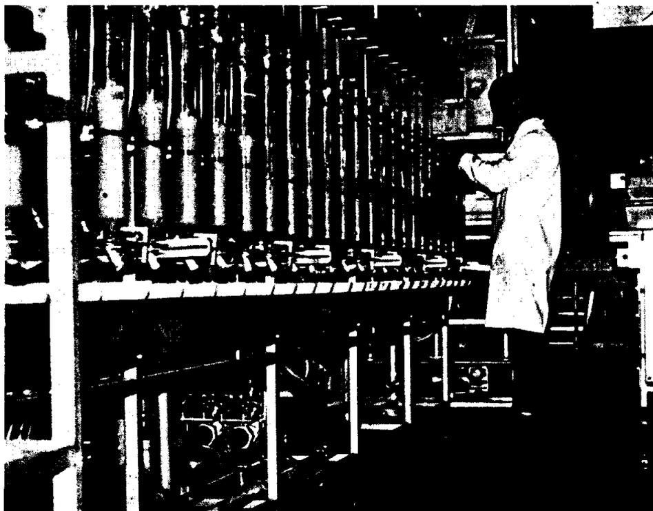
*Fig. 10.5.— Equipo granulostas para la determinación automatizada de la granulometría por el método de sedimentación discontinua.*
