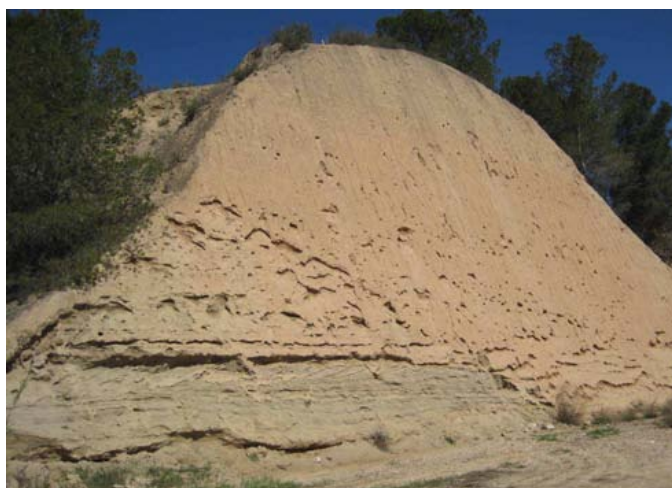
FIGURA 3. Talud junto a la carretera de Flix a Bovera (C-233), en las cercanías de Flix. El corte tiene unos 10 m de altura y en la parte superior de la imagen se aprecian limos de color ocre de aspecto masivo, que recubren unos niveles de arenas con estructuras de corriente (estratificación cruzada y paralela) las cuales forman la parte superior de la segunda terraza fluvial del río Ebro. Bajo las arenas aflora un nivel de cantos y gravas de unos 2-3 m de espesor. Fotografía: J.C. Balasch.
