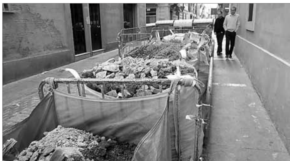
Obres a la cruïlla Perla-Verdi per instal·lar-hi les pilones i adaptar el paviment ■ RUTH MARIGOT
