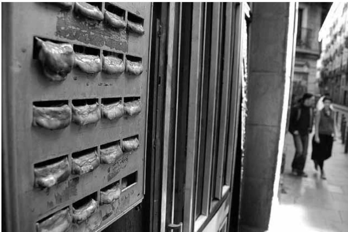
Estado en el que quedó el interfono del edificio 34 de la calle Joaquín Costa tras incendiarse los contenedores
