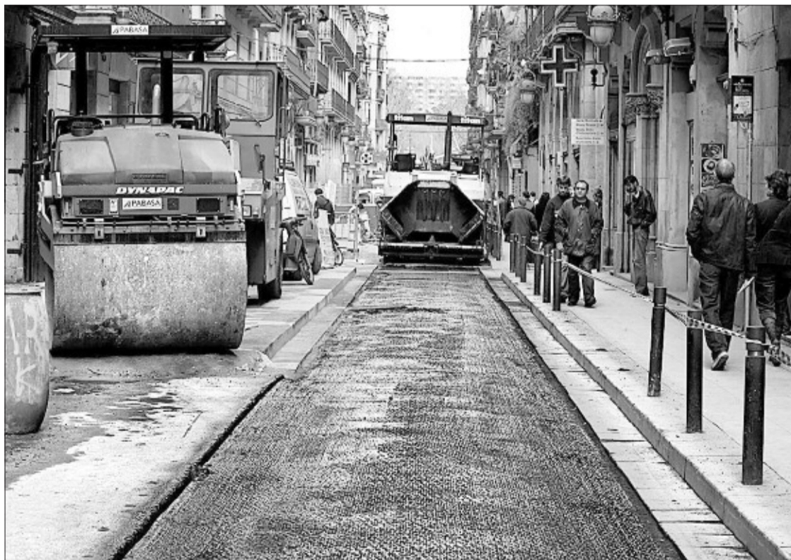
Un aspecto de los trabajos de pavimentación en la calle de Princesa. / TEJEDERAS
